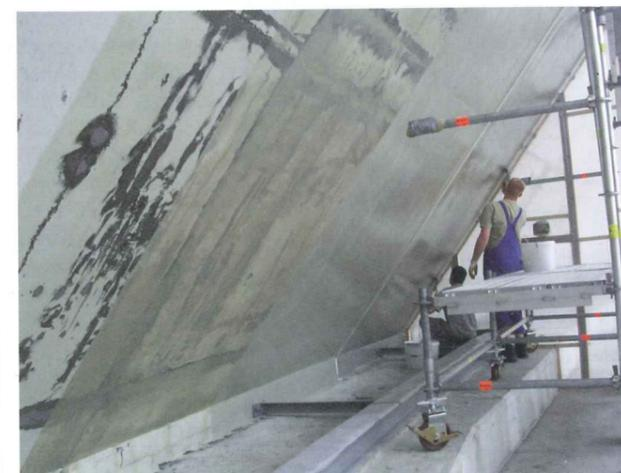
Bild 4. Beschichtungsarbeiten (Fotos: StoCretec)
