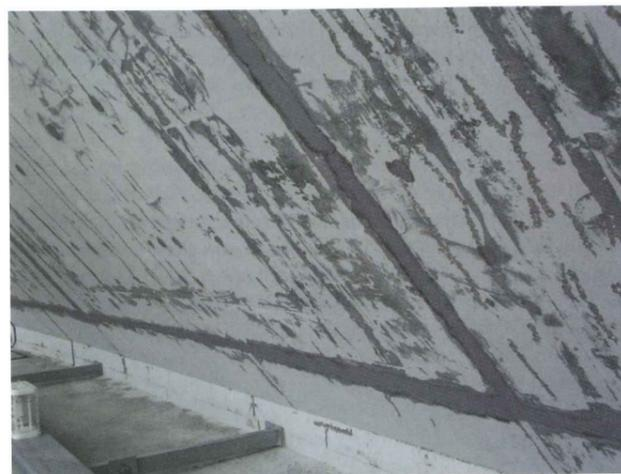
Bild 2. Vorbereiteter Untergrund der Innenschale
