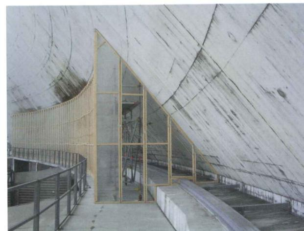
Bild 3. Abschottung durch segmentweise Einhausung
